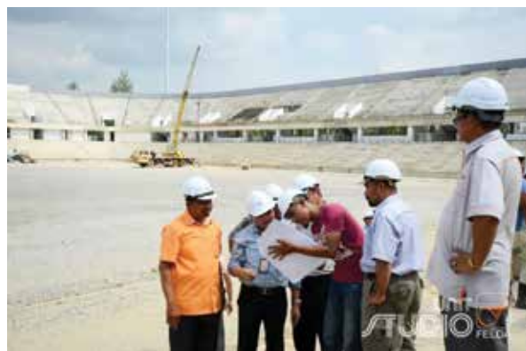
Datuk Hanapi Suhada, Pengarah Besar FELDA melawat kerja-kerja pembinaan stadium bolasepak di Bandar Pusat Jengka, Pahang
